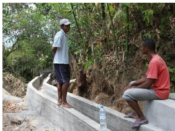
Exemple d'un micro-barrage déjà réalisé
